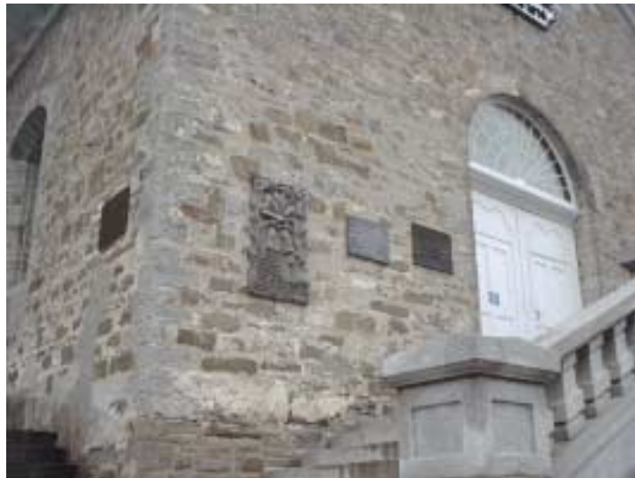
(Ste-Anne-de-Baupré ) Partie gauche de l'église. La plaque commémorant le passage des Simard se trouve à l'extrémité gauche de la façade . Elle se distingue par sa forme. Photo : S. Rompillon, mai 2003.
